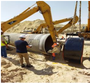
صورة رقم (10) تدعيم خارجية (اعمال استبدال الانبوب بقع خاصة)
