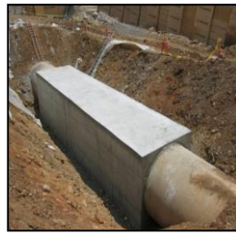
صورة رقم (9) تدعيم خارجية (تغليف بالخرسانة المسلحة) (Concrete Encasement)
