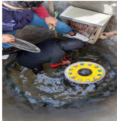
صورة (6) توضح اعمال الصيانة للمحطة 897
