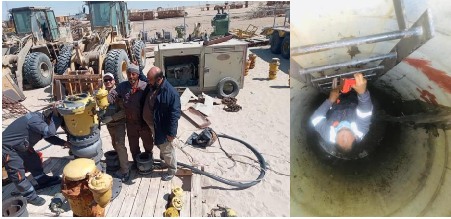
صورة (8) توضح بعض اعمال فرق الصيانة
